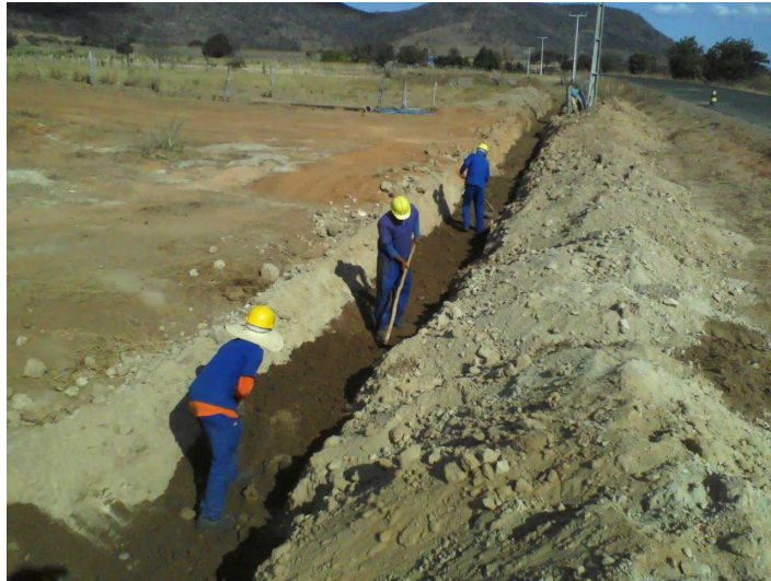
Implementação da adutora
