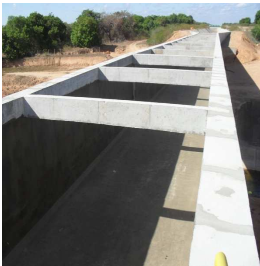
Trecho IV – Canal
